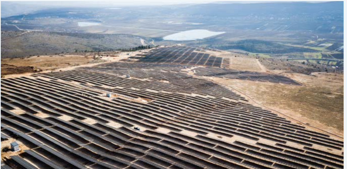
24 MW - SOLARNA ELEKTRANA, POLOG
